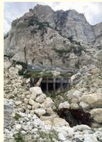
崖崩れで塞がったトンネル
