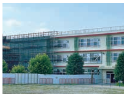
改修工事中の校舎外観
