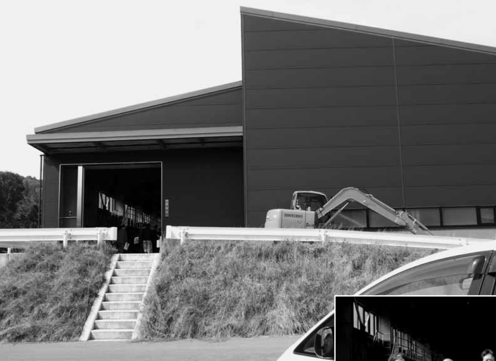
屋根と外壁で覆われたクローズド型最終処分場
