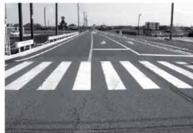
町道60号線(矢島南大島地内)拡幅工事一部完成
