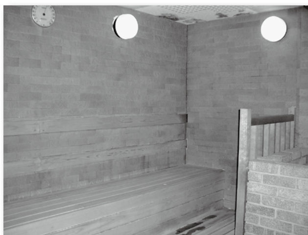
海洋センター採暖室改修
