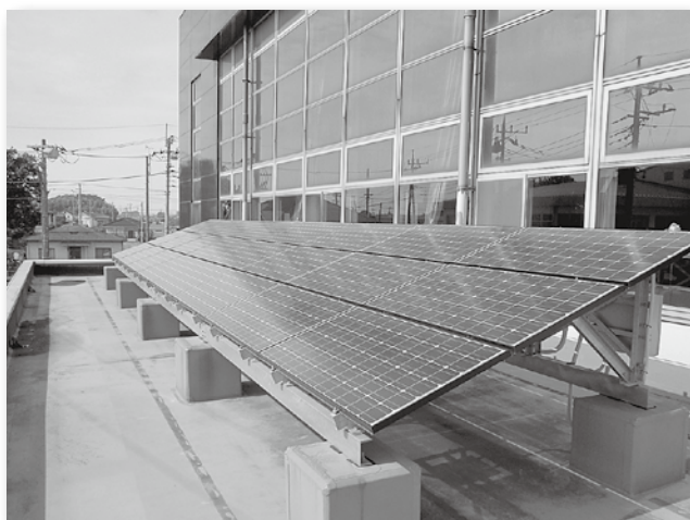
社会体育館 太陽光発電パネル設置
