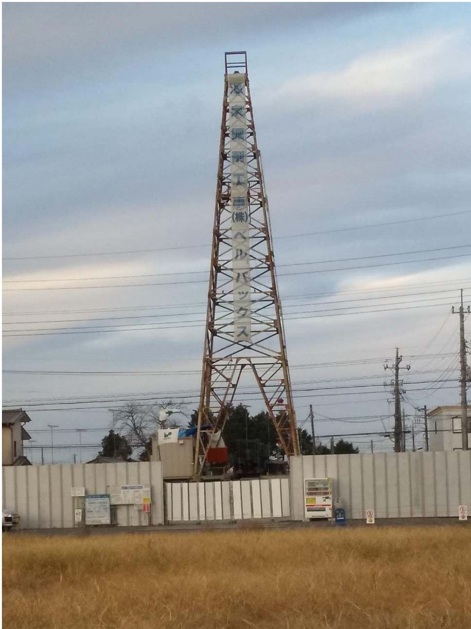
温泉掘削の櫓 地上30m
