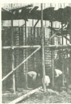
＜上＞ 用水取入口附近 ＜下＞ 取水ポンプ据付け基礎工事
