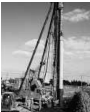
着々と進む新庁舎建設工事
