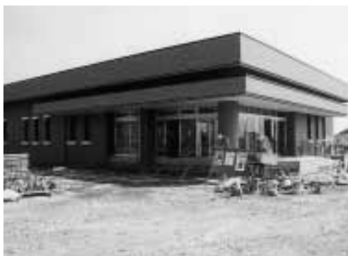
着々と進む明和水質浄化センター建設工事
