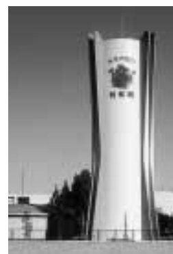
高さ30mの配水塔
