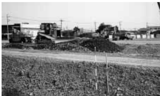
新庁舎建設に向けて着々と進む造成工事
