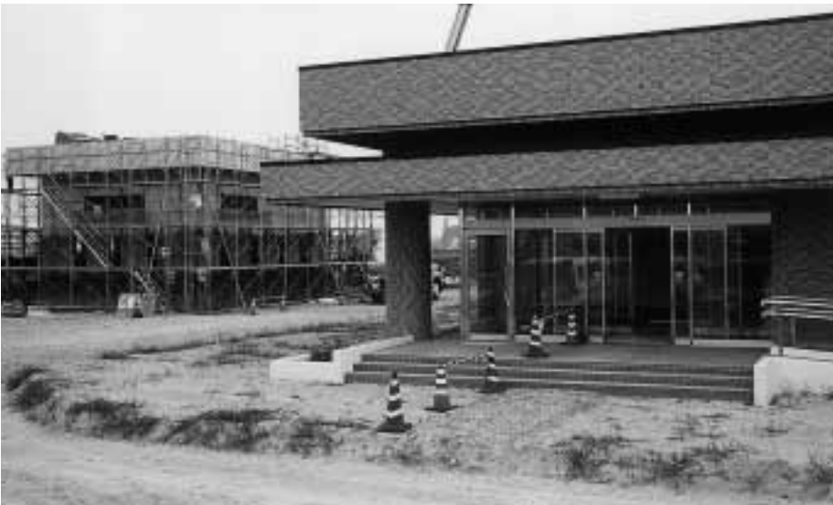
着々と進む明和水質浄化センター建設工事(左から主ポンプ棟、管理棟)
