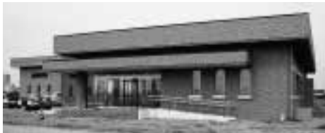
着々と進む明和水質浄化センター建設工事
