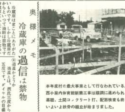
本年度最大の事業として行なわれている、西小屋内体育館新築工事は順調に進められ、基礎、土間コンクリート打、配筋検査も終り
