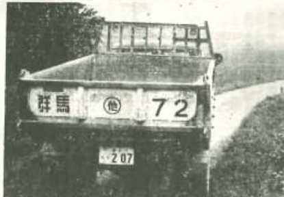
ダンフカーによる敷砂利、グレーダーによる道路整地など道路整備
