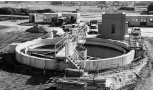
今年4月の一部供用開始に向け工事が進む水質浄化センター
