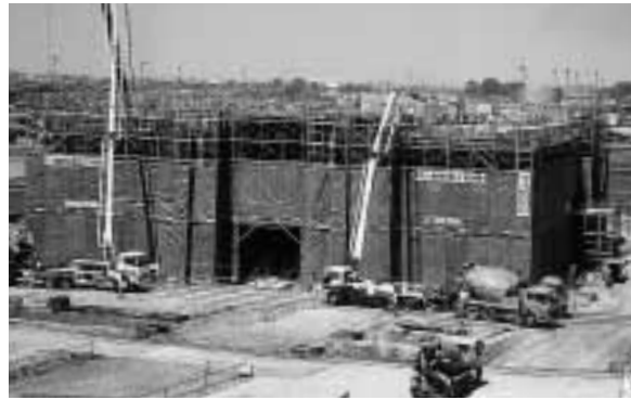
着々と進む新庁舎建設工事
