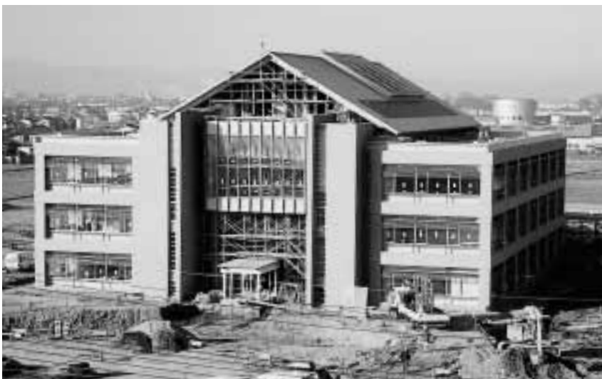
建設中の役場新庁舎
