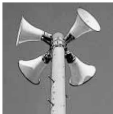
屋外放送施設
