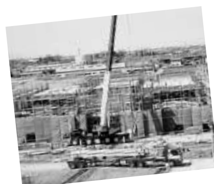
⑤2階立ち上がり部工事 16.3.31
