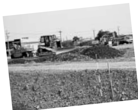
①建設地で造成工事 15.6.6
