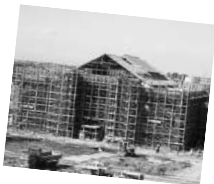
⑥新庁舎各階建設工事 16.10.25
