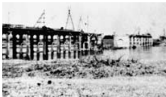
増水で流失した中央部の修理工事
