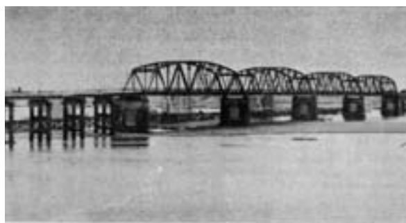
ワーレントラス4連を架けて復旧後の「昭和橋」
