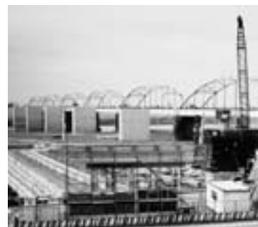
平成 11 年から始まった橋脚建設
