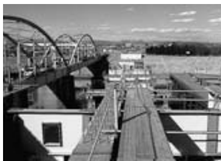
新橋上部工事（桁の上から群馬側を望む）
