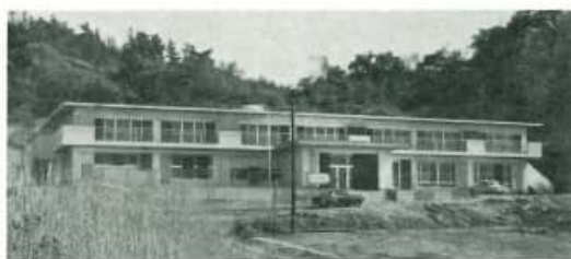
完成した臨海学校
