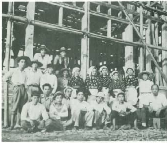
これは昭和二十七年八月、千江田中学校校舎（現在東小学校的木造校舎）新築工事に男女青年団員が勤労奉仕をしたときの写真です。私は当時建築委員として一緒に働きました。（私は前列の右端です）（係では、思い出写真」を募集しています。ふらってどうぞ！！）
