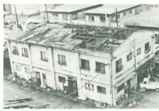
屋根を飛ばされた橋本産業株
