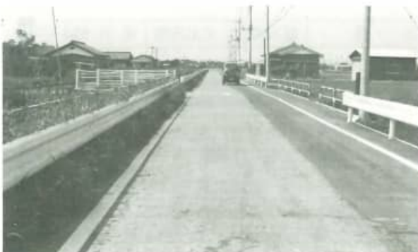
道路改良整備
