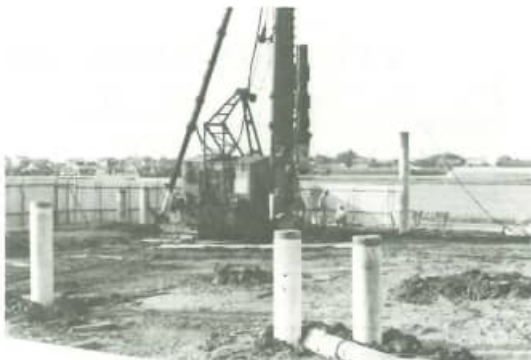
急ピッチで進められる建設工事
