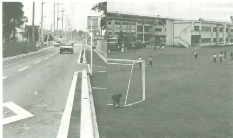
道路改良整備
