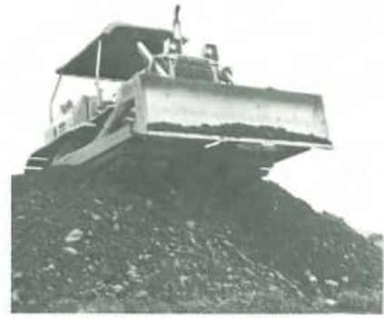
▲建設重機で急ピッチの造成現場
