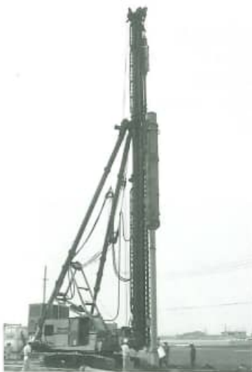
くい打ち スタート
