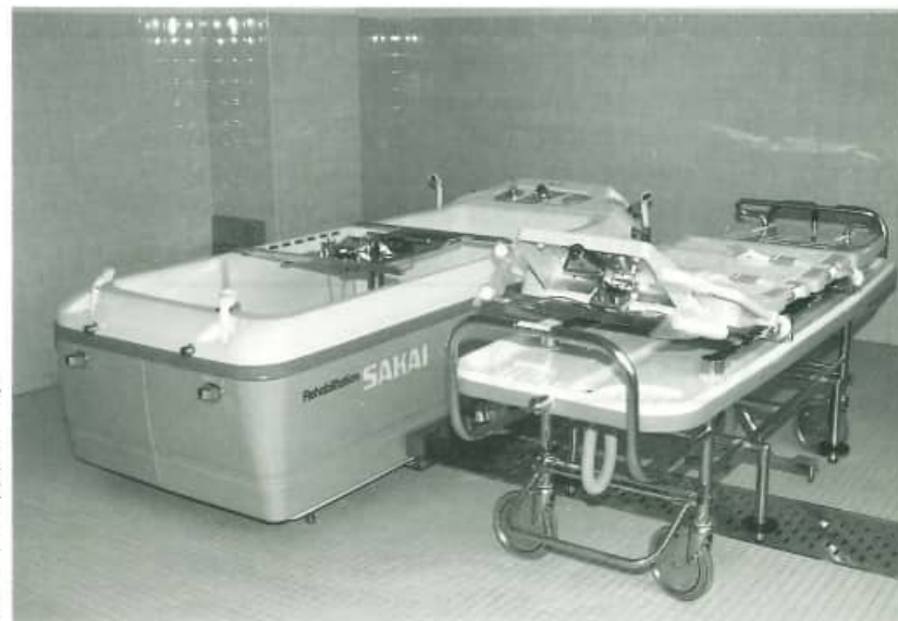
デイサービスセンターのメインである機械浴室
