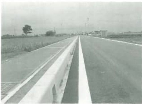
▲拡幅・改修された道路
