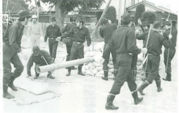
▶水防工法訓練（月の輪工法）
