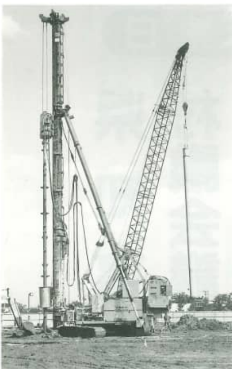
ふるさと産業文化館建設工事
