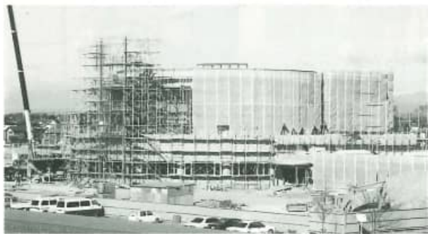
▲着々と工事が進むふさと産業文化館
