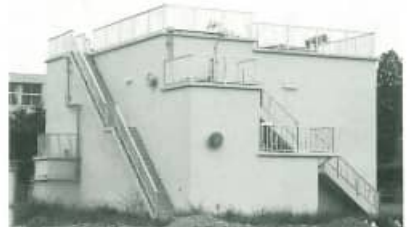
第4次拡張事業により整備中の第5浄水場
