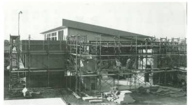
建設が進む学校給食センター
