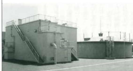
完成した南大島浄水場
