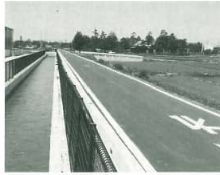
邑楽用水路改修工事に伴い整備した村道
