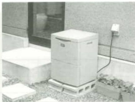
勝手口の軒下に設置
