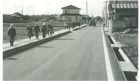
大型車両が進入する通学路
