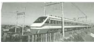
川俣駅・羽生駅間複線化
