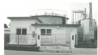
改修された上江黒浄水場
