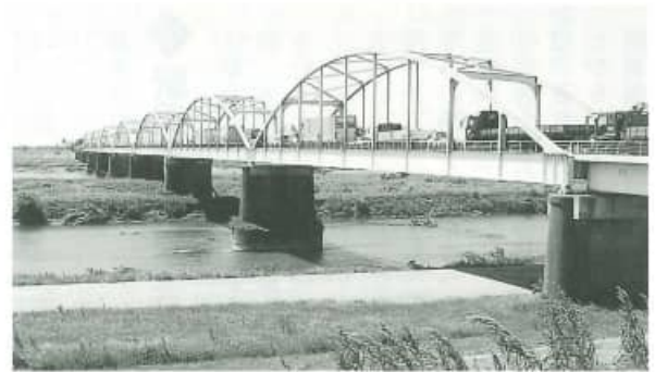
新しく橋が建設される昭和橋の下流側
