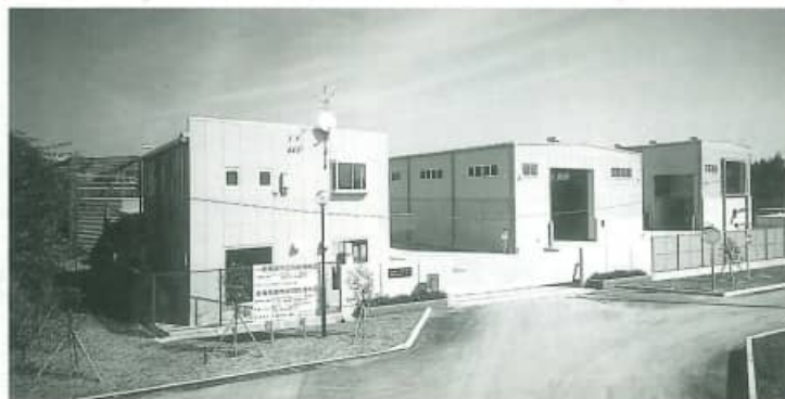
一般廃棄物中間処理施設
