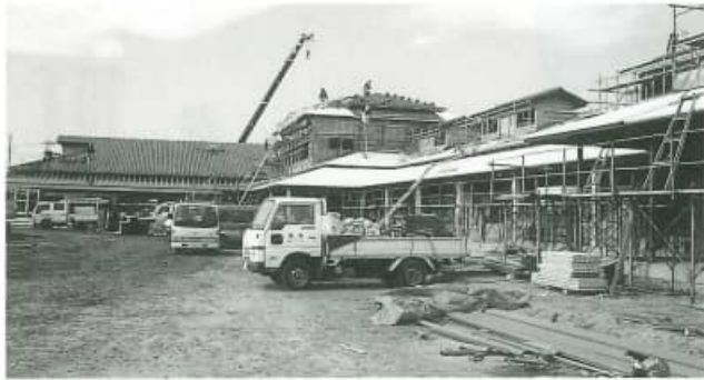
着々と工事が進む明和保育園舎
