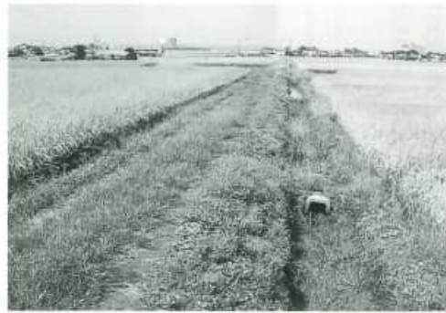
新里地内の町道2-275線
