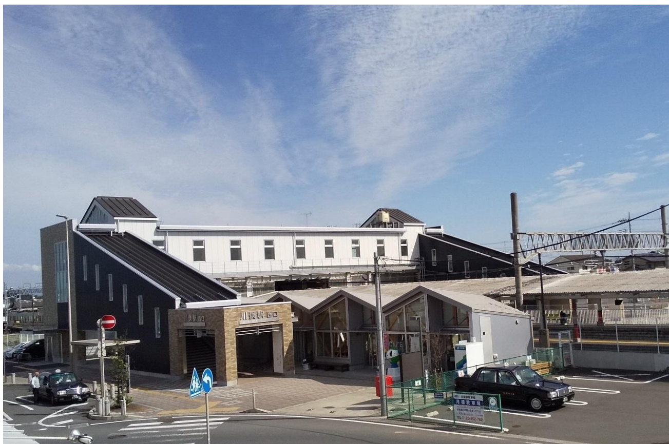
【2016年1月に竣工した現在の川俣駅】
