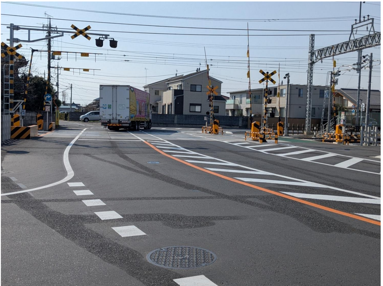
【大型車が楽々通れる広い踏切に生まれ変わりました】
