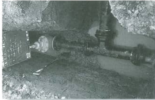
布設替えされた水道管
