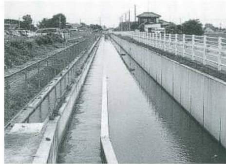
三面コンクリートに改修された佐貫排水
