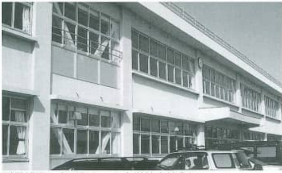
耐震補強工事が行われた中学校南校舎
