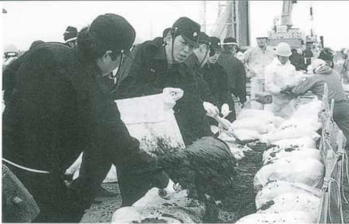
▲越水防止工法(フルコンシート)を披露
