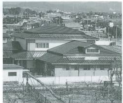
▲屋根面に取り付けられた空気ソーラーシステム
