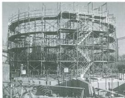
着々と進む上水道配水塔築造工事
