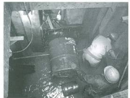
地下約5mでの推進機到達状況
