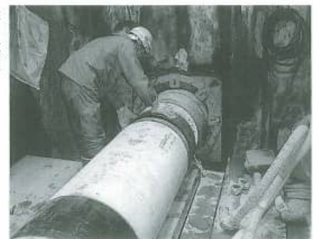
地下約9mで行われている下水道管の推進工事
