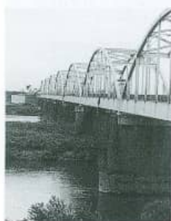
架け替えが予定されている 国道122号昭昭和橋
