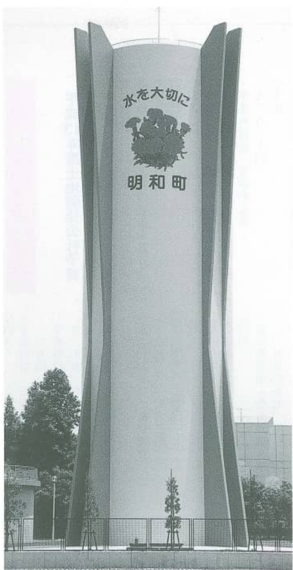
自然流下方式の配水塔（西側）
