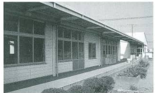
介護予防の拠点施設となる(仮)社会福祉会館に改修工事される旧中央幼稚園舎
