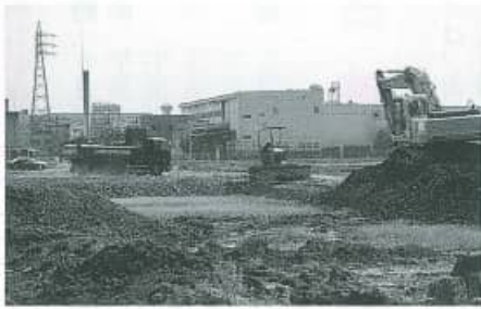
11月完成を目指し進められている造成工事
