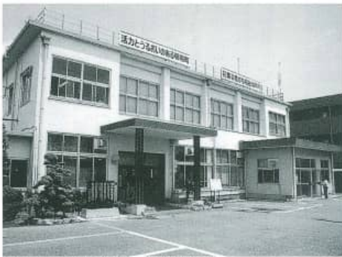
昭和31年に建設された役場庁舎
