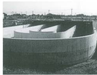
着々と進む水質浄化センター工事
