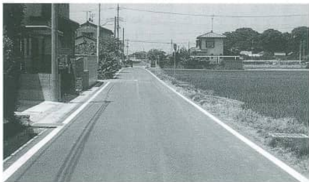
道路改良工事が行われた町道（3型）
