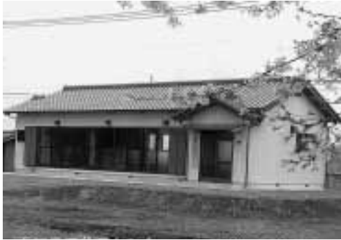
完成した上江黒区住民センター
