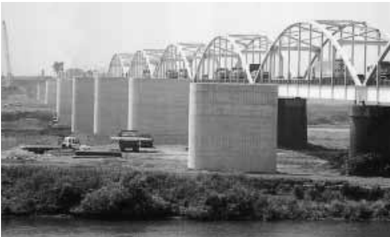
着々と進む昭和橋の橋脚建設工事
