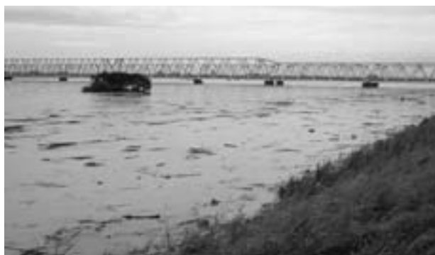
増水した利根川（東武伊勢崎線鉄橋付近）
