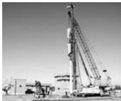
開始される杭打ち工事
