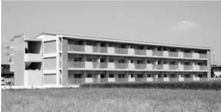
完成した町営住宅新田団地A棟
