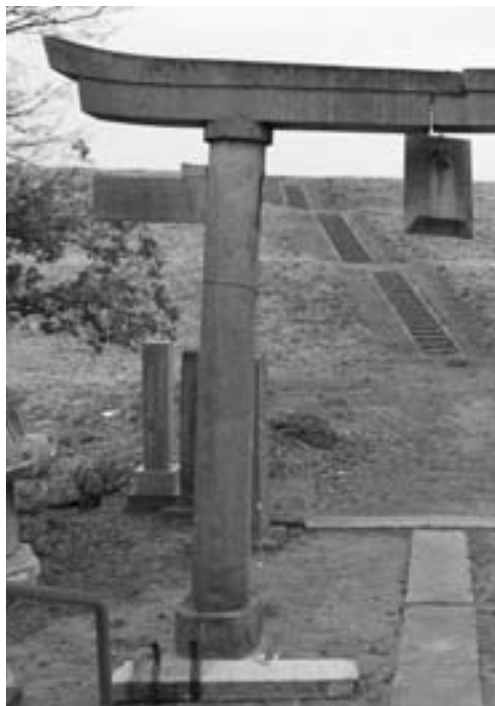
亀裂が入り倒壊寸前の鳥居（江口地区）
